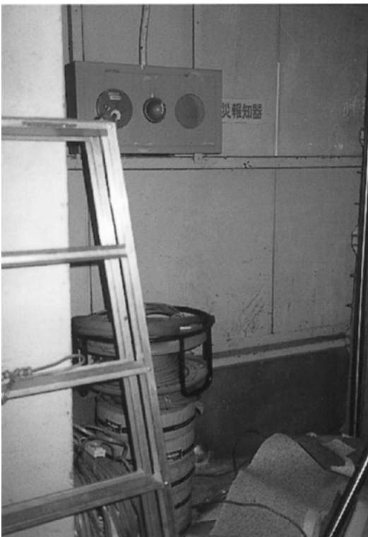
非常ベルの前に物を置いている。 避難通路妨害。
